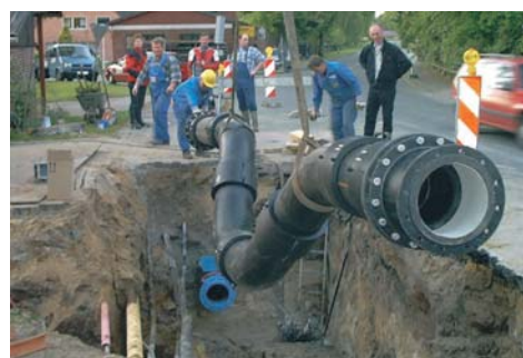
Unterqueren eines Schmutzwasserrohres mit der Trinkwasserleitung
